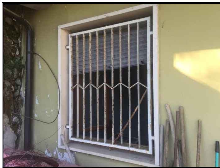
Foto 8 – finestra del vano deposito sito al piano terra del fabbricato
