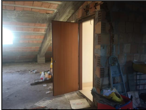
Foto n°9 – accesso dal vano scale al locale sottotetto
