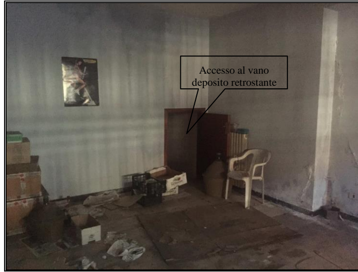
Foto n°4 – ambienti interni al locale box con vista del vano deposito retrostante
