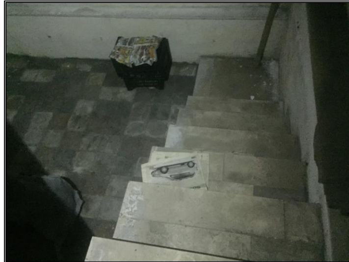
Foto n°5 – scala di accesso al vano deposito retrostante il locale box
