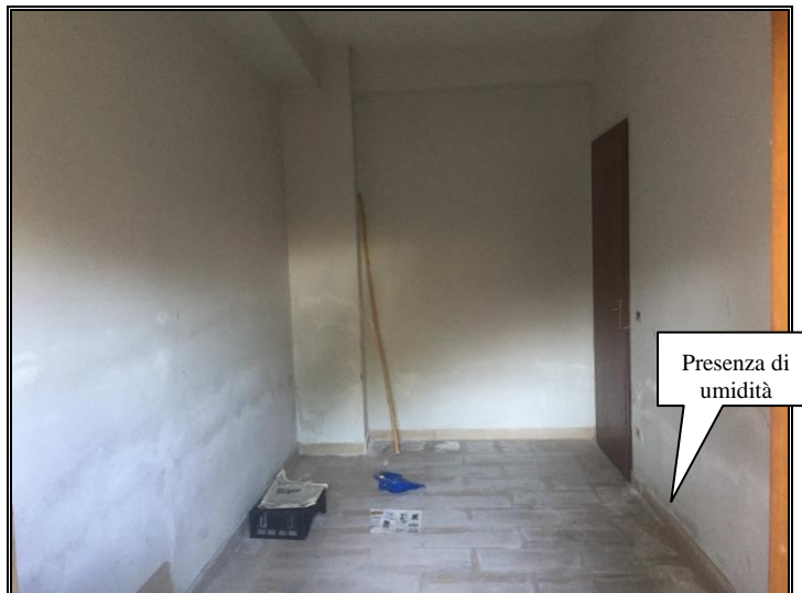
Foto 7 – vano deposito sito al piano terra del fabbricato
